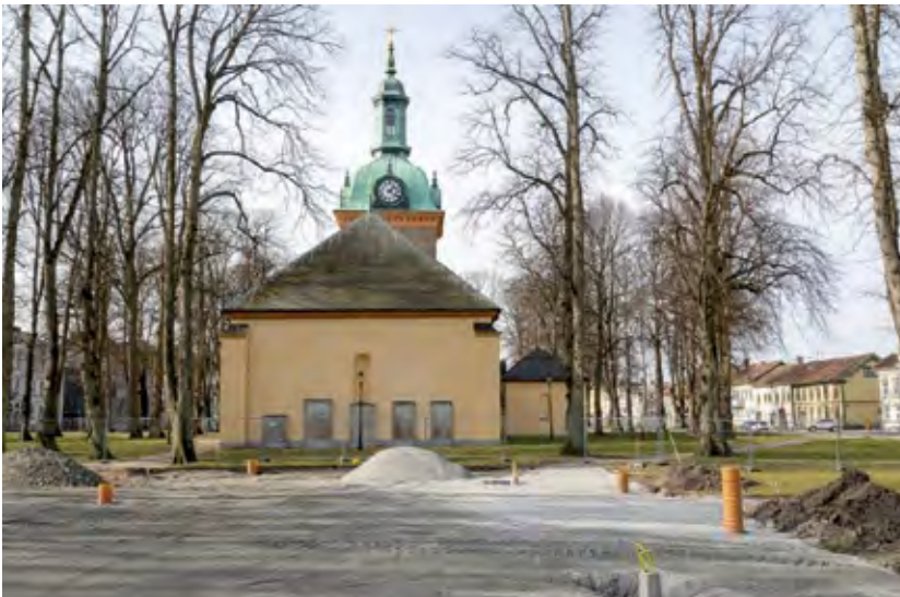
Anläggningsarbete i Kyrkoplantaget mars 2015. Foto: Karl Bernling.
