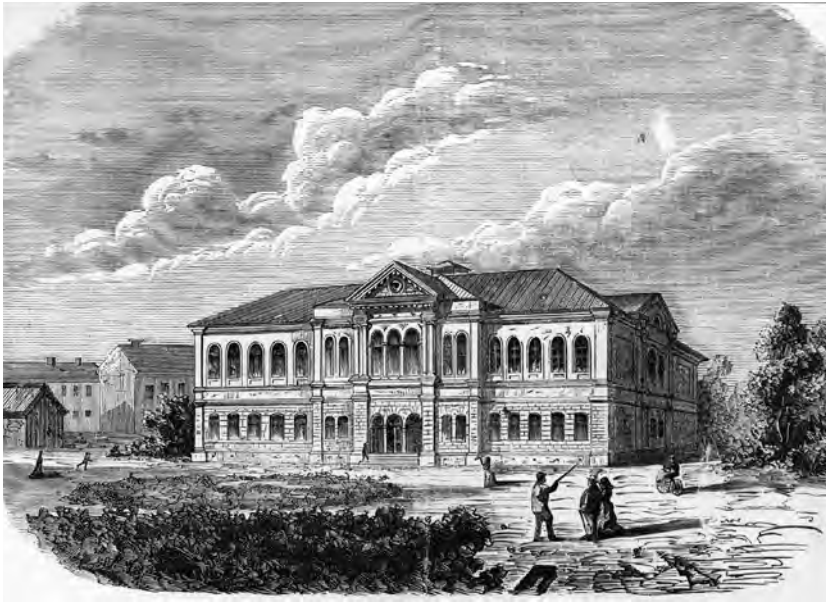
Den gamla apologistskolan visade sig snart för trång sedan den omvandlats till läroverk och antalet lärare och elever ökade. Problemen avhjälpes då man höstterminen 1869 kunde inviga denna ståtliga nya läroverksbyggnad, uppförd efter ritningar av Per Ulric Stenhammar. Ur Ny Illustrerad Tidning 1870.
