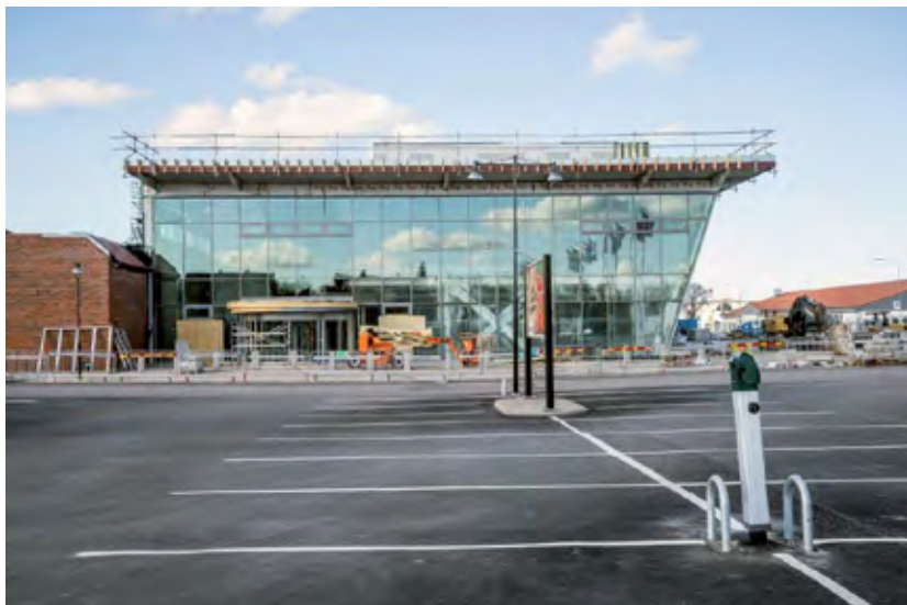
Willys parkering och den nya gallerian vid Trenova april 2015. Foto: Karl Bernling.
