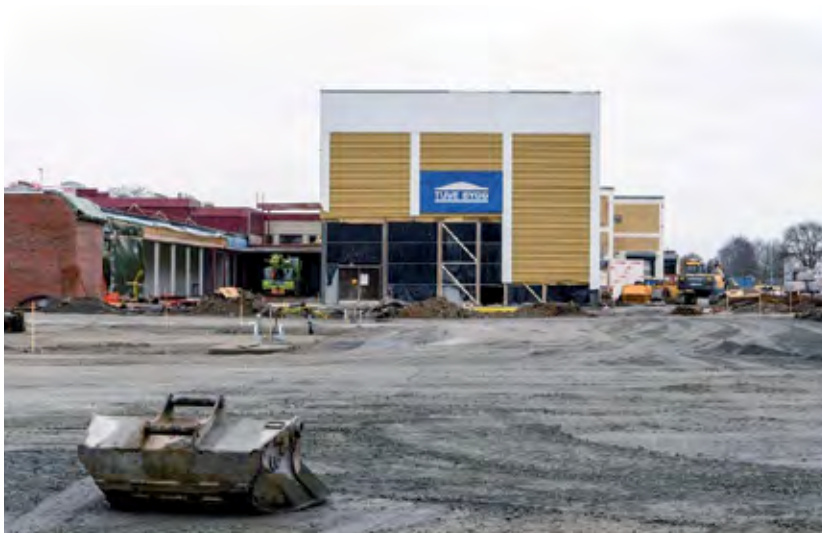
Arbete med ny galleria vid Trenova november 2014. Foto: Karl Bernling.
