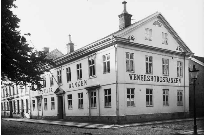
Wenersborgsbanken vid förra sekelskiftet. Postkontoret var inrymt i bottenvåningen. Källa: Vänersborgs museum.
