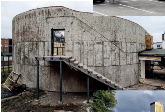
Kommunhusets sessionssal under rivning November 2018 Foto Karl Bernling
