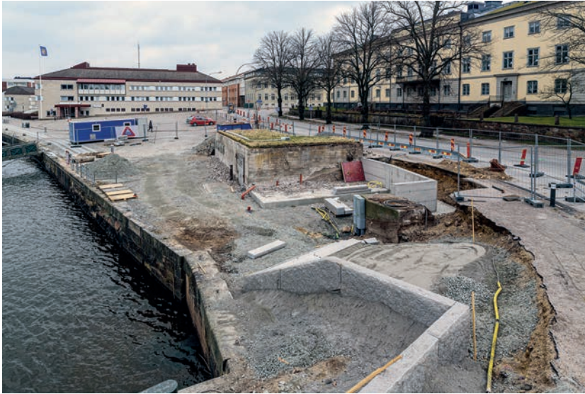
Anläggningsarbete vid Fisktorget Mars 2019 Foto Karl Bernling
