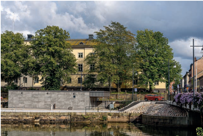
Nyanlagd trappa och renoverade toaletter vid Residensbrons norra sida Augusti 2019 Foto Karl Bernling
