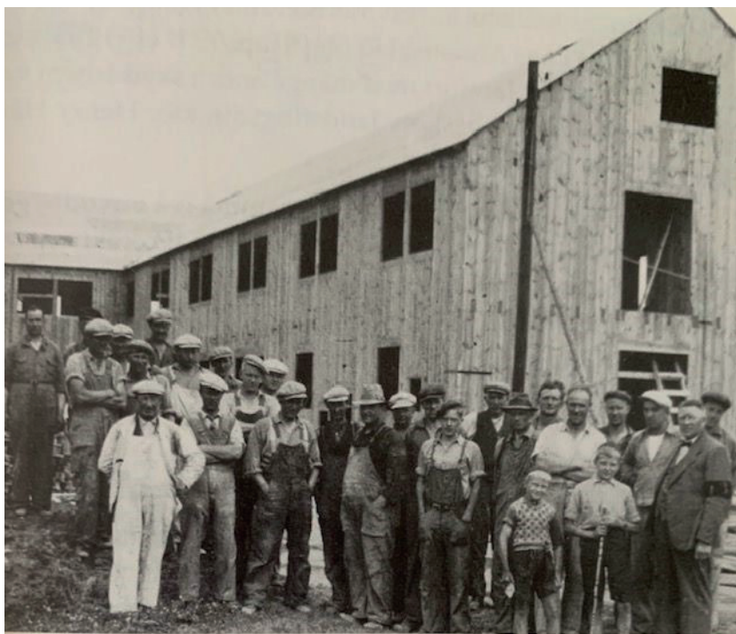
Byggnadsarbetarna framför huvudbyggnaden 1938. Andre man från höger byggmästare Enoch Svensson och framför hans två barn.
