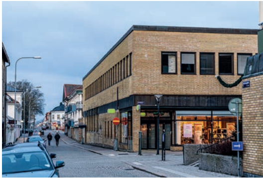
Systembolagets gamla läge i korsningen Residensgatan Sundsgatan Januari 2019 Foto Karl Bernling
